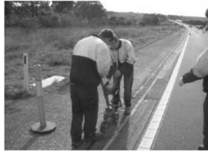
图 5 安装光纤光栅应变传感光缆
