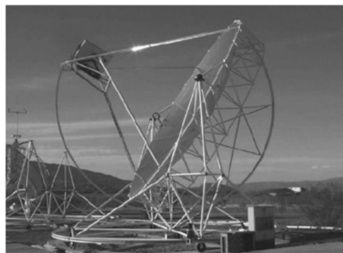
图2 西班牙 EuroDish 碟式聚光发电系统 Fig. 2 “EuroDish” solar dish concentration system in Spain
